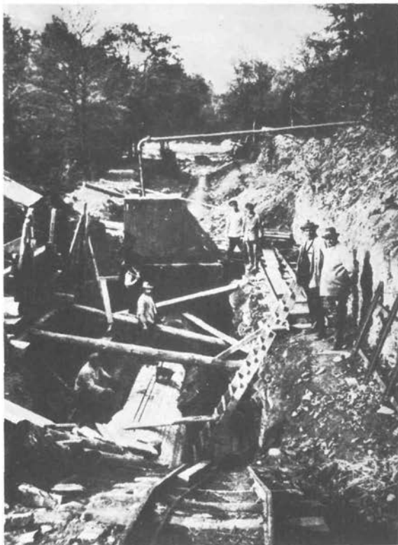
Abb. 8. Bau des Grundwasserstollens 1928/29 (fot. Lörmecke-Wasserwerk)
