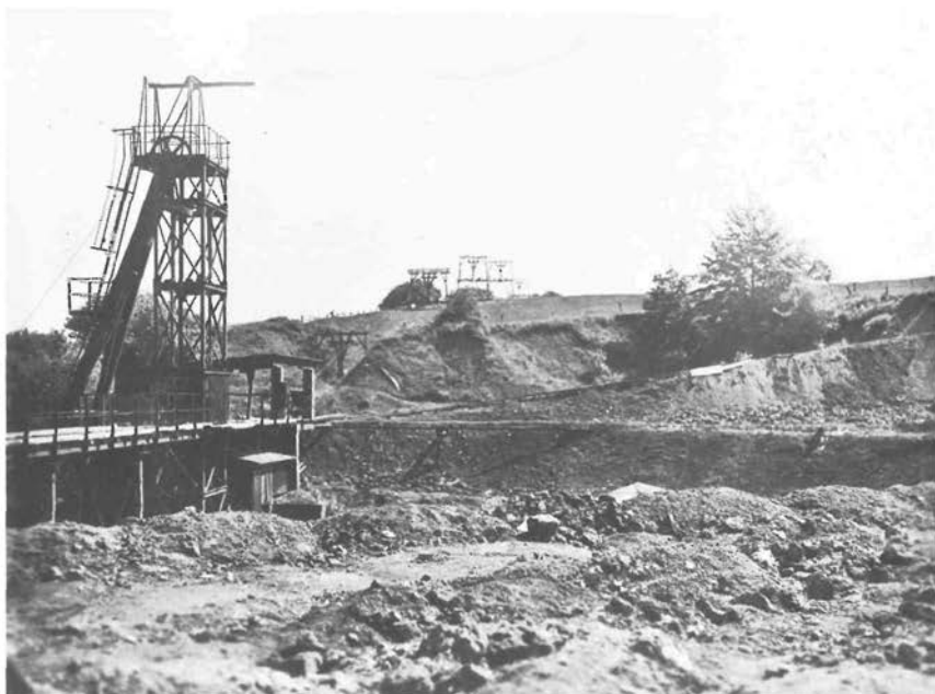
Abb. 3. Grube David (Christiansglück) mit Seilbahn, im Bau (1938).
